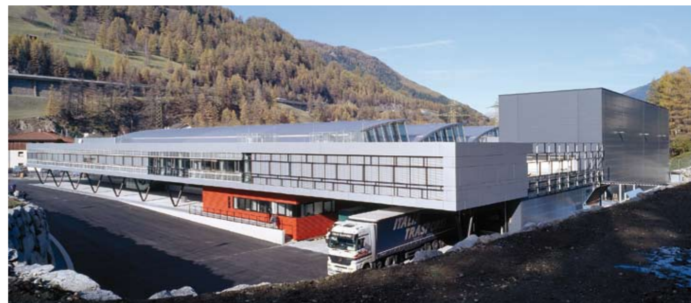
Vorzeigeprojekt: ATP realisierte im Wipptal das GWM Gerätewerk Matrei, bestehend aus Produktionshalle und Hochregallager.
